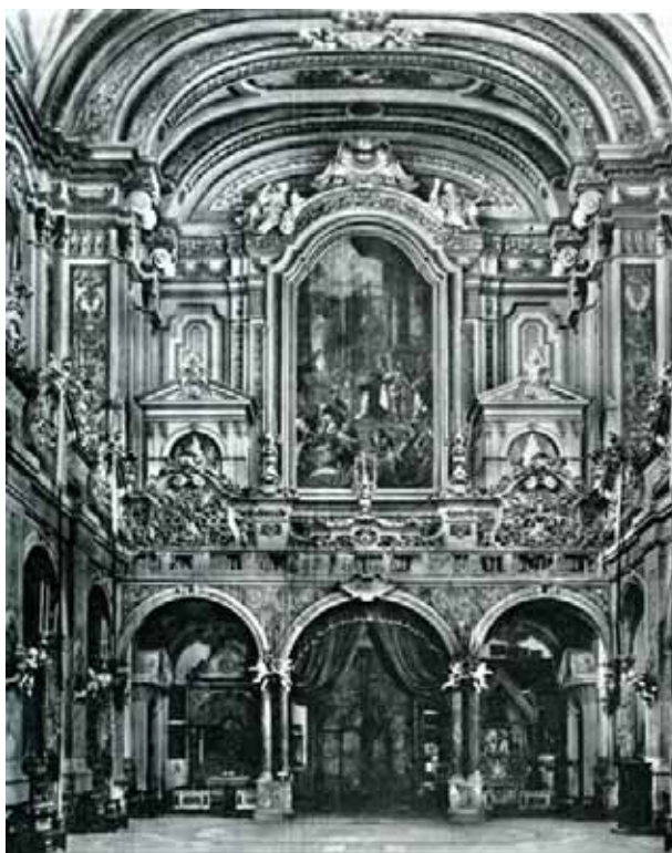
Figura 5. S. Chiara: la controfacciata della basilica settecentesca, prima del bombardamento. (Foto: Dell'Aja, Il restauro )
